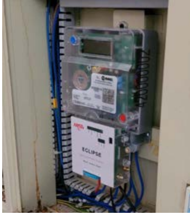
Resim 7: Makel Üç fazlı PRO Elektrik Sayacı üzerinde Eklips modemi
