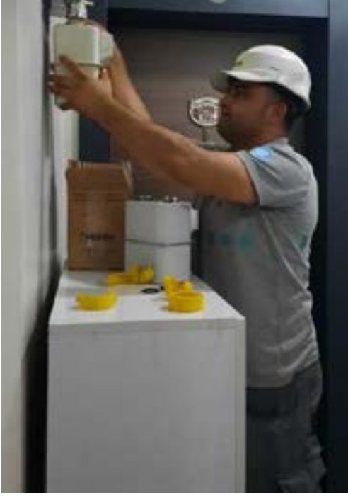
Resim 4: Gaziantep Doğalgaz Sayaçları değişimi ve sonrası
