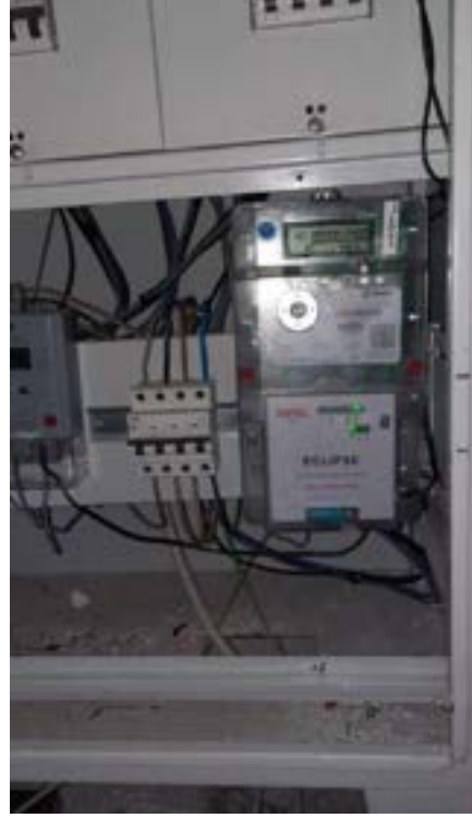
Resim 3: Gaziantep Elektrik Sayaçları ve Modem Montaj görünümü
